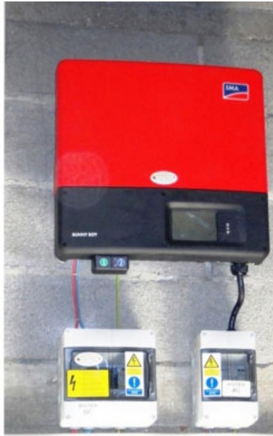
Générateur PV de 2.9Kwc composé de 10 panneaux bi-verre de 290Wc de marque SCHOTT avec intégration bacs acier SEN et onduleur SMA. Installation visée par le Consuel sur démarche volontaire (non obligatoire à cette époque).
