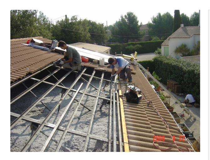
Générateur PV de 2.97Kwc composé de 18 panneaux de Schott solar de 165Wc sur bacs acier SEN et onduleur SMA. Installation visée par le Consuel sur démarche volontaire (non obligatoire à cette époque).
