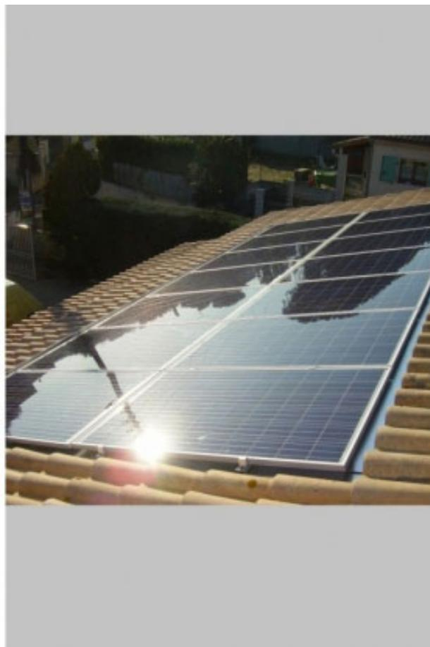
*Générateur PV de 2.97Kwc composé de 14 Solarworld de 214Wc sur intégration intersole et onduleur SMA. Installation visée par le Consuel sur démarche volontaire (non obligatoire à cette époque).*
