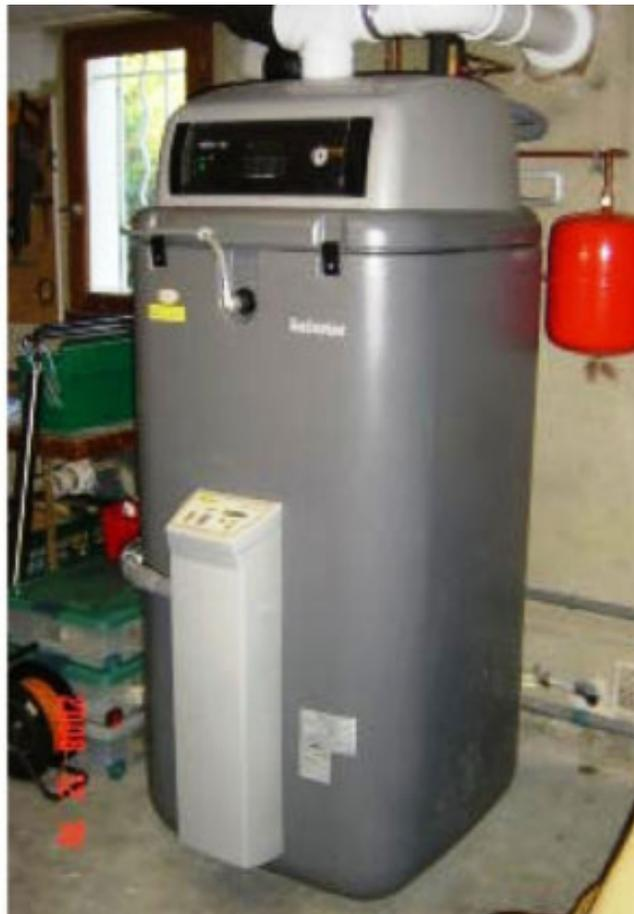
*Combiné solaire avec couplage chaudière gaz condensation GSU25 Daikin Rotex avec 4 panneaux V26p, permettant d'assurer l'eau chaude sanitaire et une partie de chauffage en hiver grâce au solaire. Désembouage installation avec solution Permo. Ventouse concentrique horizontale de marque Cheminées Poujoulat.*
