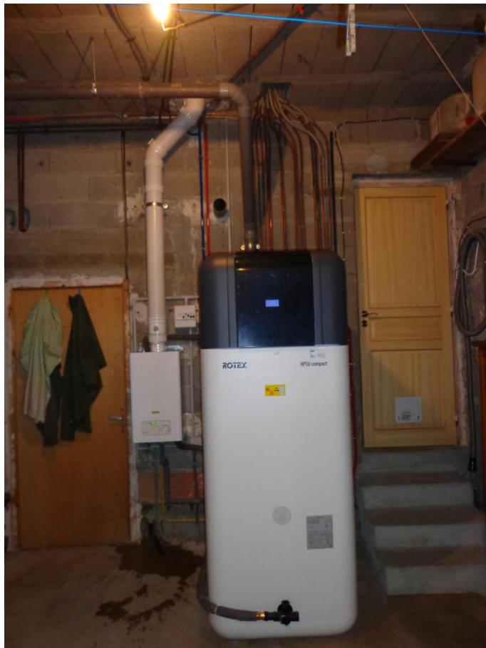
*Remplacement d'une ancienne chaudière gaz vétuste par un système tri énergies, constitué d'une pompe à chaleur Rotex/Daikin HPSU compact, d'une chaudière à condensation Rotex/Daikin G-plus et couplage d'un poêle bois hydraulique existant. Filtration du circuit chauffage par pot à boues avec traitement circuit par solution Solutech Permo. Ventouse concentrique Verticale de marque Cheminées Poujoulat.*
