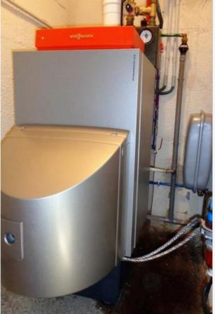
Remplacement d'une ancienne chaudière fioul énergivore, par une chaudière à condensation fioul de marque Viessmann modèle Vitorondens 200T avec régulation Vitotronic 200 en fonction de la température extérieure.
