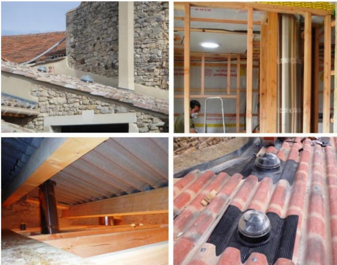
*Dans une ancienne maison en rénovation complète, installation de deux puits de lumière de marque Solatube dans une future salle de bains à l'étage modèle 160 DS et dans un séjour en rez de chaussée modèles 290 DS. Le plus lumineux des puits de lumière et le plus performant dans, 13 Bouches du Rhône, dans, 13 Bouches du Rhône, 30 Gard, 84 Vaucluse.*
