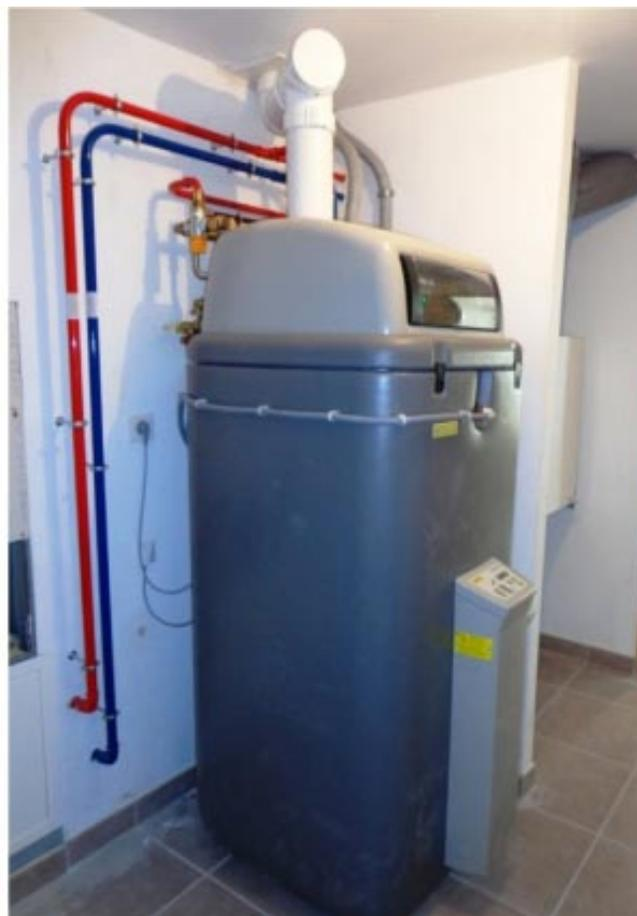
*Mise en place d'un système combiné solaire SSC de marque Daikin Rotex composé de 4 panneaux H26P couplés à un générateur Rotex GSU25 assurant l'eau chaude sanitaire et une partie du chauffage sur plancher*
