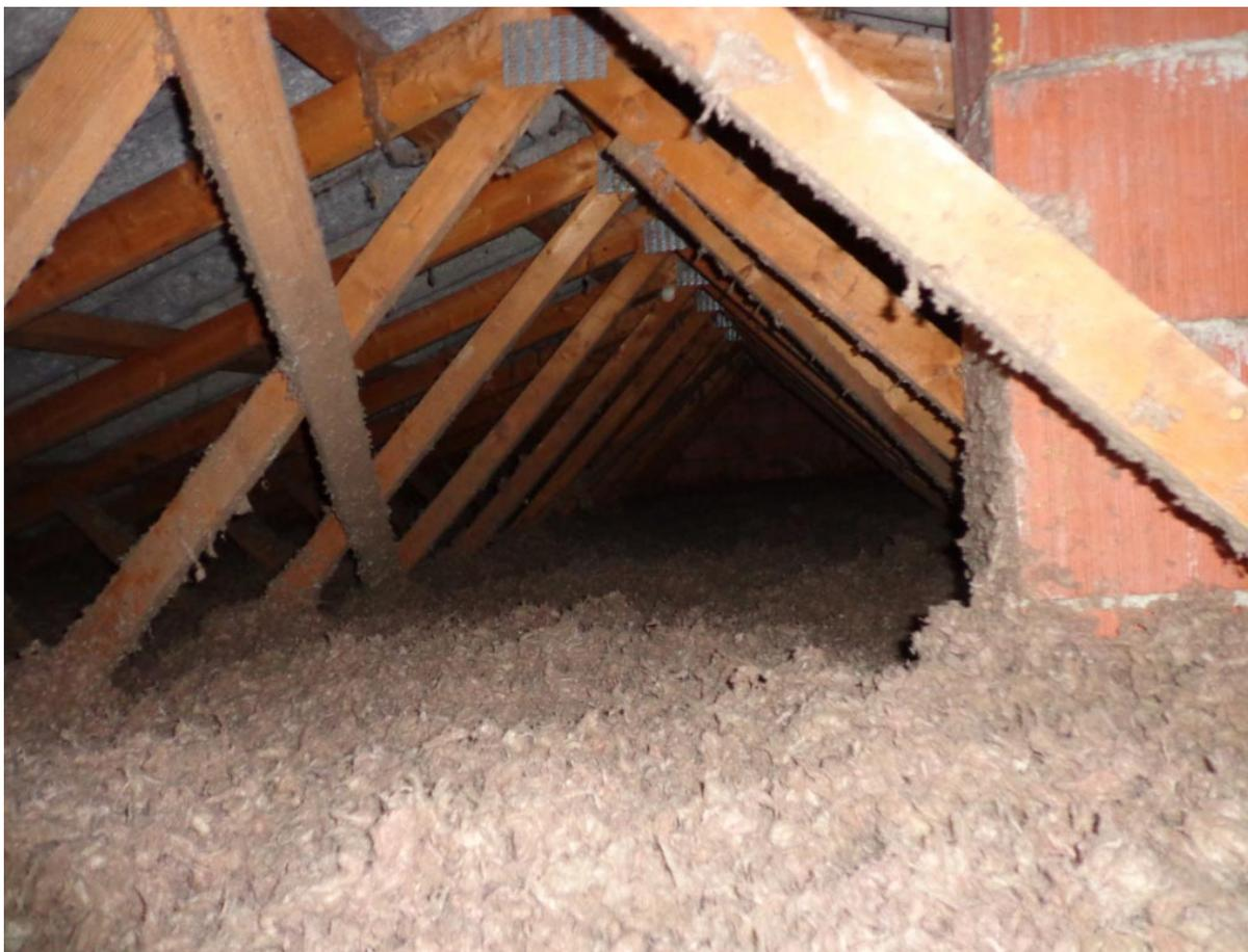
*Après la mise en place d'une VMC simple flux de marque Atlantic, soufflage dans les combles perdus de laine de roche de marque Rockwool de type jetrock sur une épaisseur de 32cm pour un R=7*
