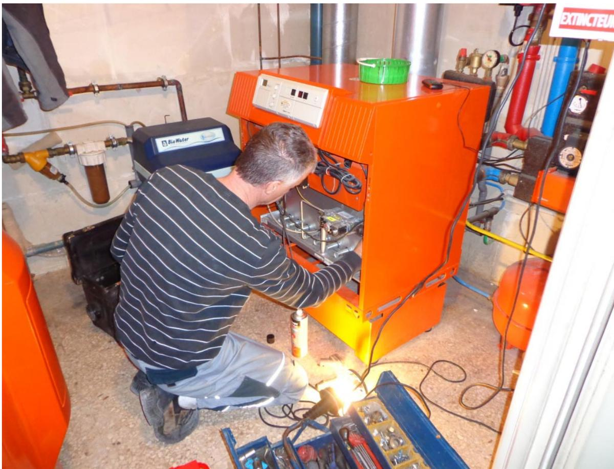
*Entretien annuel d'une chaudière gaz Viessman avec nettoyage chaudière, brûleur, ramonage du conduit de fumées, contrôle électronique de combustion, et contrôle visuel état chaudière.*
