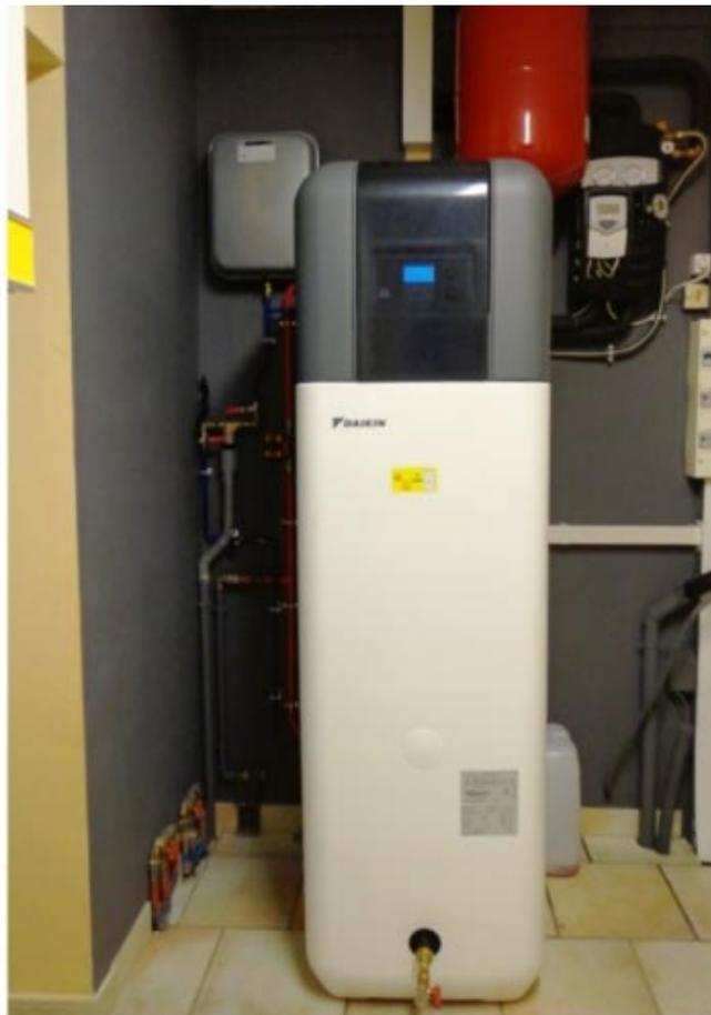
*Après dépose du ballon solaire existant et de la chaudière électrique, désembouage du plancher chauffant et des radiateurs avec pose d'un pot à boues Permo.*
