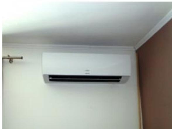
*Dans une maison de village chauffée avec des convecteurs énergivores, nous avons proposé et installé afin de réduire la facture énergétique, un climatiseur Bi-splits de marque Atlantic.*
