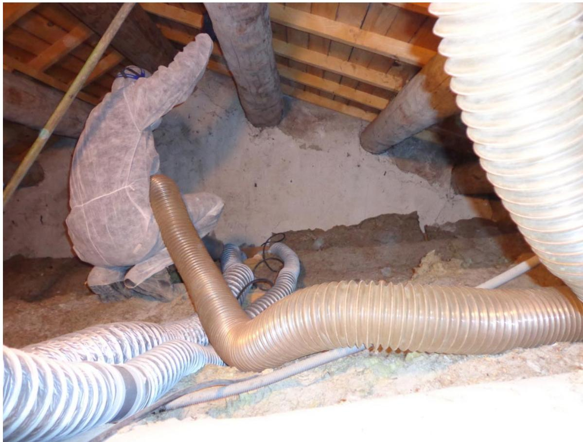
*Suite à un important problème d'humidité dans un appartement ancien non ventilé et mal isolé, nous avons conseiller la mise en place d'une VMC simple flux de marque Atlantic et d'un complément d'isolation dans les combles perdus avec laine de roche soufflée de marque Rockwool type Jetrock sur une épaisseur de 32cm complémentaire.*
