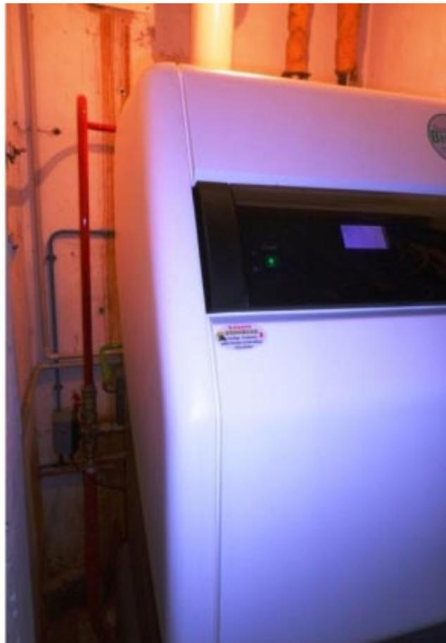
*Remplacement d'une ancienne chaudière fuel dans un sous sol exigü par une chaudière à condensation fuel de marque Daikin Rotex modèle A1 équipée d'une régulation RonCon et d'un ballon d'eau chaude sanitaire en inox de 150 litres. Mise en place dans l'ancien conduit d'une ventouse verticale de CheminéesPoujoulat. Désembouage circuit radiateurs avec solution Solutech Permo avec filtre à boues.*
