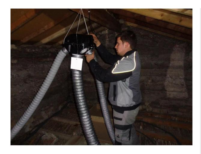
Dans un maison des années 50 et avant le soufflage de l'isolation, mise en place d'une VMC simple flux de marque Atlantic modèle Autocosy afin d'améliorer la qualité de l'air intérieur. Trois bouches d'extractions sont installées dans la cuisine le wc et la salle de bains et 6 entrées d'air de 30m3/h sont posées sur les fénêtres PVC existantes.
