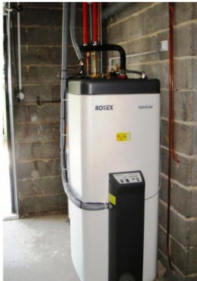
*Mise en place d'un chauffe-eau solaire de 300 litres avec 2 capteurs plan V21P de marque Daikin Rotex avec relèvement automatique de la chaudière durant les périodes non ensoleillées.*
