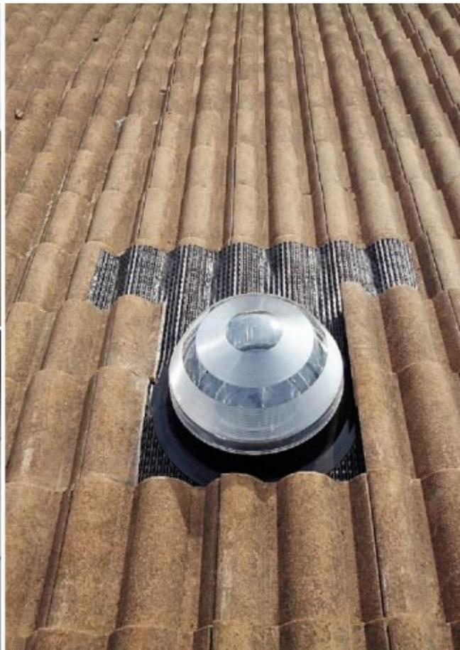
*Dans un séjour mal éclairé, installation d'un puits ou conduit de lumière de marque Solatube modèle 290DS. Le plus lumineux des puits de lumière dans, 13 Bouches du Rhône, 30 Gard, 84 Vaucluse.*
