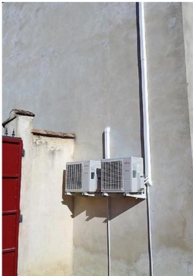
*Climatisation d'un séjour et d'une chambre avec appareils de marque Atlantic. Le choix de 2 monosplits fût choisi par le client afin de pouvoir garder un appareil fonctionnel en cas de panne sur unité extérieure.*
