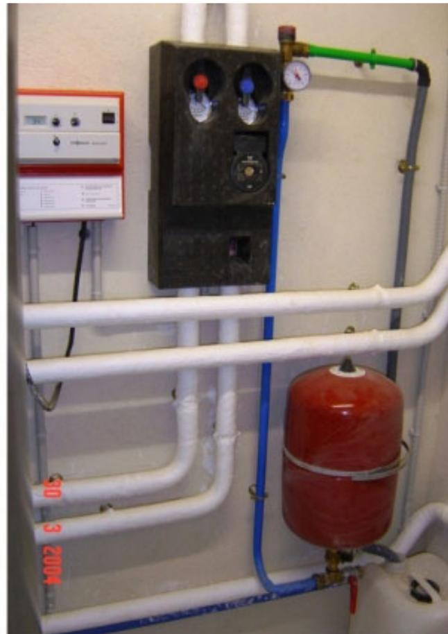
*Chaudière à condensation gaz couplée avec chauffe-eau solaire viessmann en intégration toiture avec ballon 300 litres Inox. Désembouage installation avec solution Permo. Ventouse concentrique horizontale de marque Cheminées Poujoulat.*
