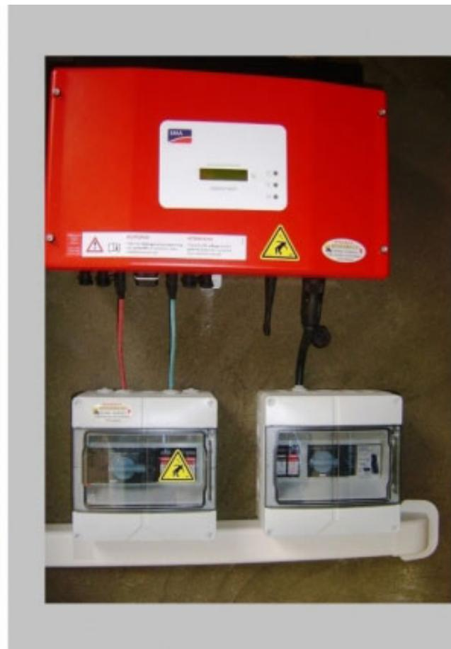
*Générateur PV 2.94KWC de marque Solarworld avec intération intersole et onduleur SMA. Installation visée par le Consuel sur démarche volontaire (non obligatoire à cette époque).*
