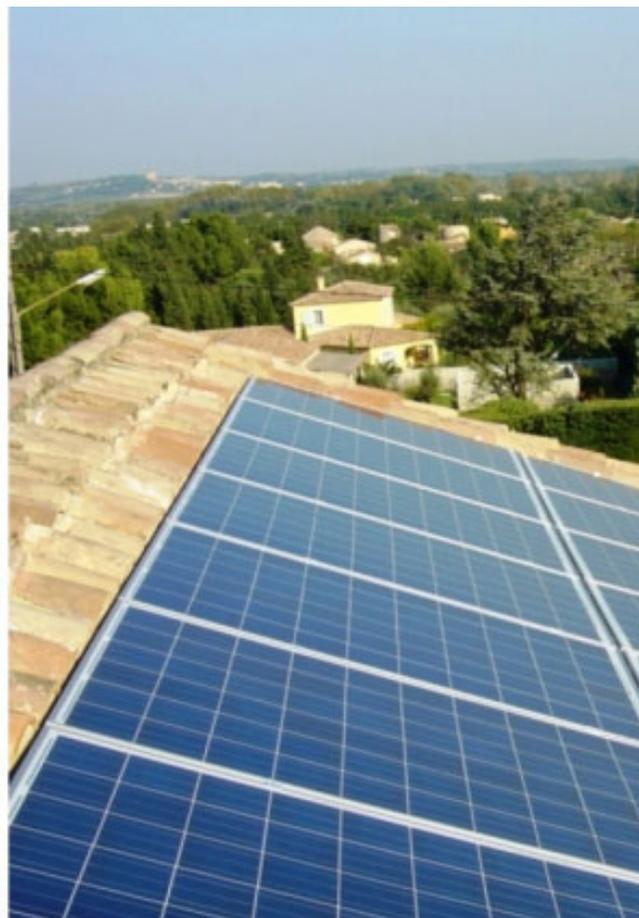
*Installation sur toiture avec anciennes tuiles canal scellées au mortier, d'un générateur PV de marque SOLARWORLD sur integration Ubbink et onduleur SMA et coffrets pare foudre AC et DC. Installation visée par le Consuel sur démarche volontaire (non obligatoire à cette époque).*
