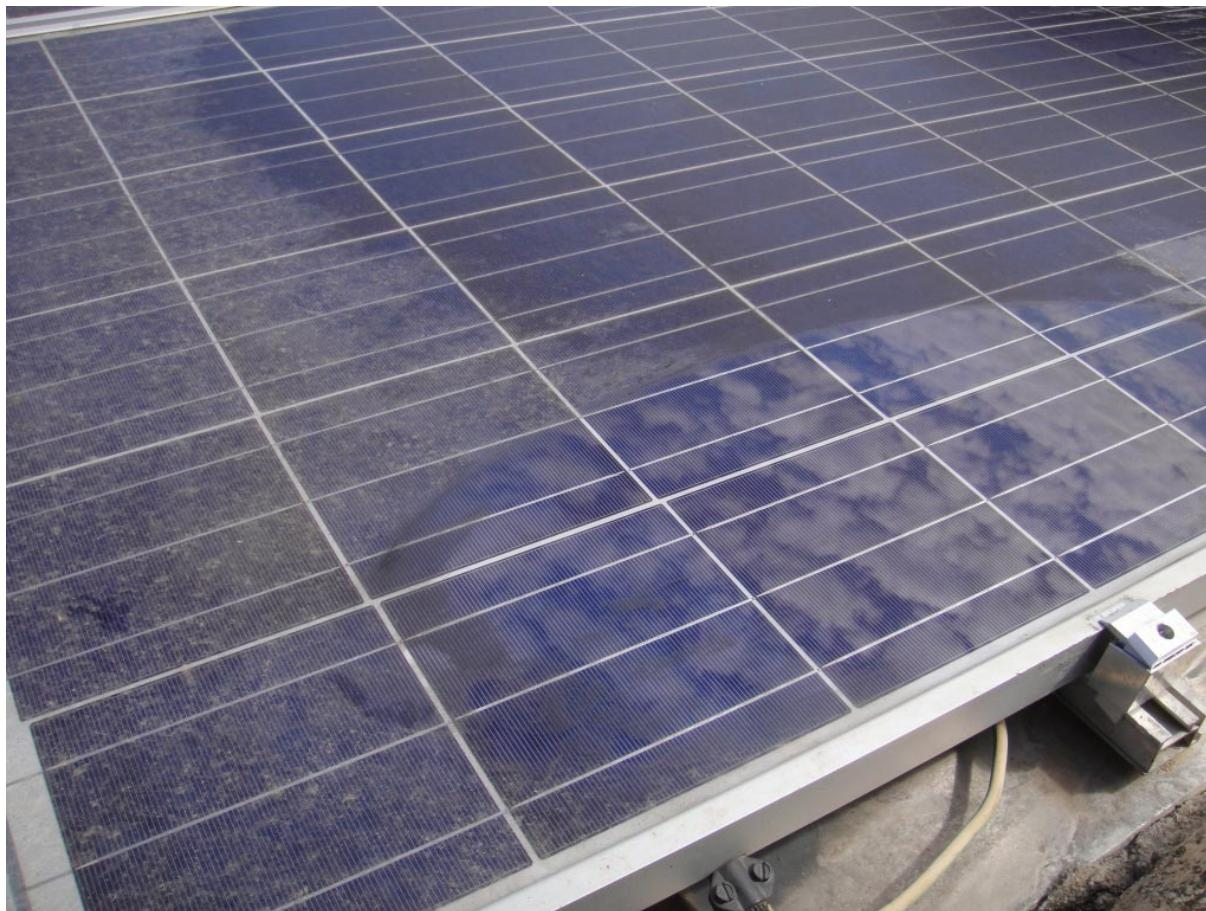
*Afin de restaurer la production énergétique des capteurs photovoltaïques installé depuis 2008, un nettoyage s'imposait, vu de l'état de salissure.*
