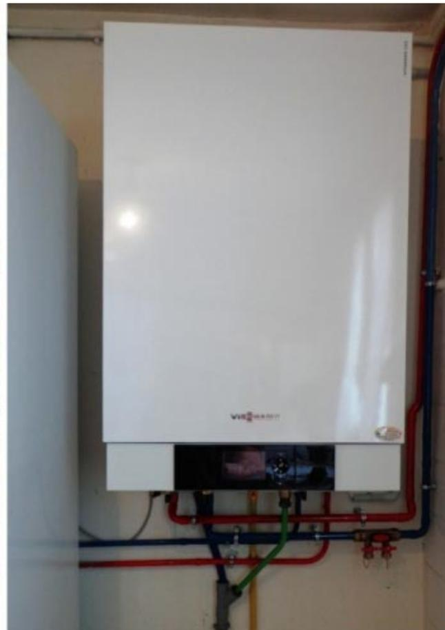
*Remplacement d'une ancienne chaudière gaz énergivore, par une chaudière à condensation de marque Viessmann, modèle Vitodens 222-W dotée d'une régulation Vitotronic 200 fonction de la T° extérieure et d'un ballon d'eau chaude sanitaire de 46 litres en inox. Traitement d'eau du circuit radiateurs par solution Permo. Ventouse concentrique horizontale de marque Cheminées Poujolat.*
