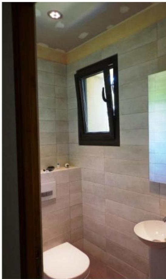
*Réfection complète d'un coin toilette avec wc suspendu et lave mains. Remplacement de l'ancien lustre par Des spots à leds encastrés dans un faux plafond.*
