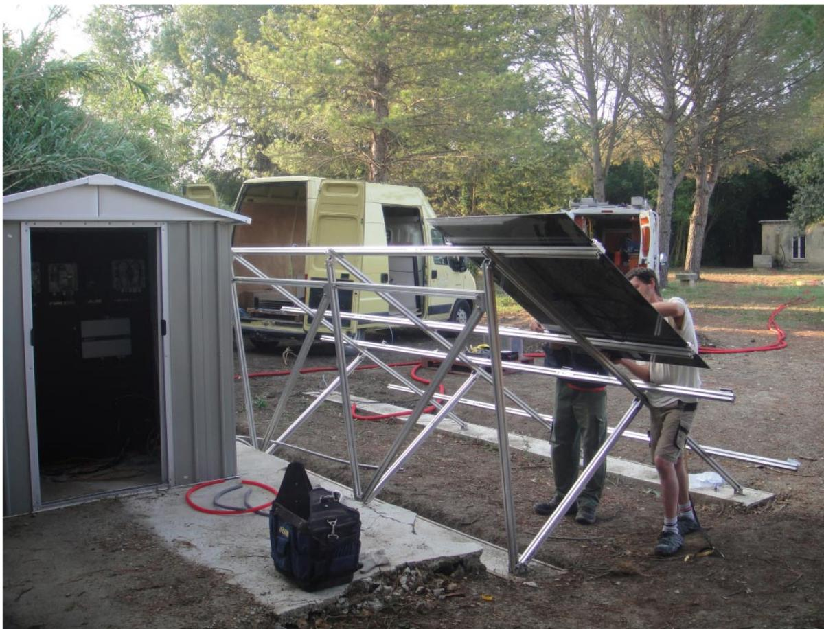
*Sur un site isolé mise en place de 6 panneaux bi-verre amorphe de marque Sharp pour alimenter la filtration d'un piscine au fil du soleil grace à un drive schneider. Puis pour alimentation d'un cabanon en 220v mise en place de 2 panneaux Benq avec stockage sur batteries et onduleur pour alimenter, éclairage, réfrigérateur TV et pompe de puits.*
