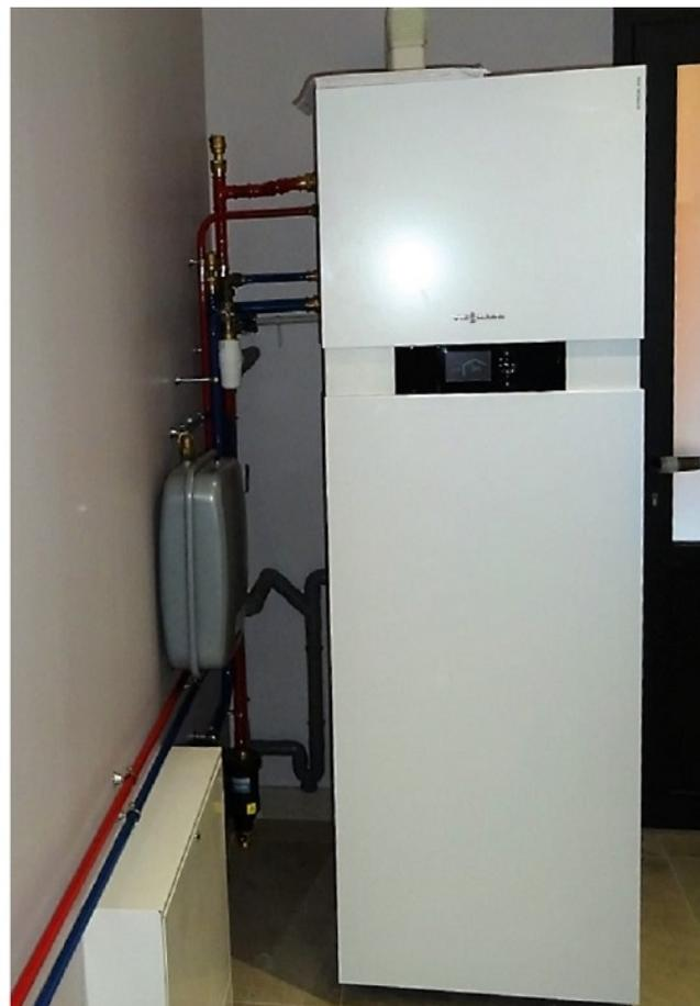
*Installation sur plancher chauffant d'une pompe à chaleur silencieuse de marque Viessmann modèle Vitocal 222-S avec production d'eau chaude et régulation fonction de la température extérieure. Mise en place sur le réseau d'un pot à boues Dirmag plus et traitement de l'eau avec solution solutech de chez Permo. Installateur Proactif Viessmann 30 GARD 84 VAUCLUSE Cette PAC pourra être raccordée à des panneaux photovoltaïques.*
