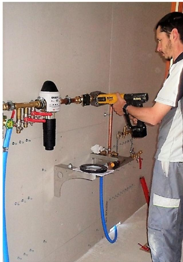
*Installation d'un réseau de distribution sanitaire avec filtre a tamis inox de marque Judo modèle Speedy qui permet de protéger l'installation.
