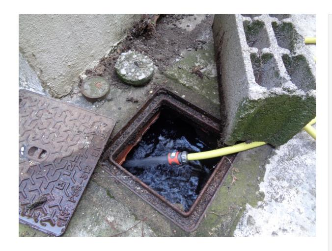
Suite au remplacement d'une chaudière, pose d'un pot à boues de marque Caleffi modèle Dirtmag sur la tuyauterie retour et d'une vanne by-pass sur la tuyauterie aller. Rinçage installation avec machine Rems flush puis en fin de désembouage lorsque l'eau coule claire, injection solution Solutech de chez Permo
