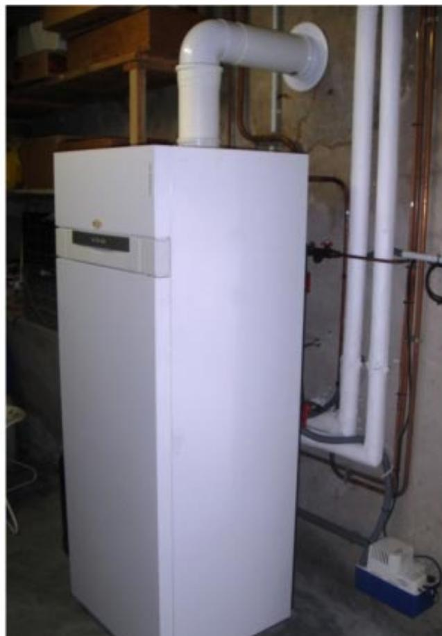
*Remplacement d'une ancienne chaudière gaz peu performante, par une chaudière gaz à condensation de marque Viessmann modèle Vitodens 333-F avec production d'eau chaude sanitaire par ballon de 130 Litres. Désembouage circuit radiateurs avec solution Solutech de chez Permo. Ventouse concentrique Poujoulat.*
