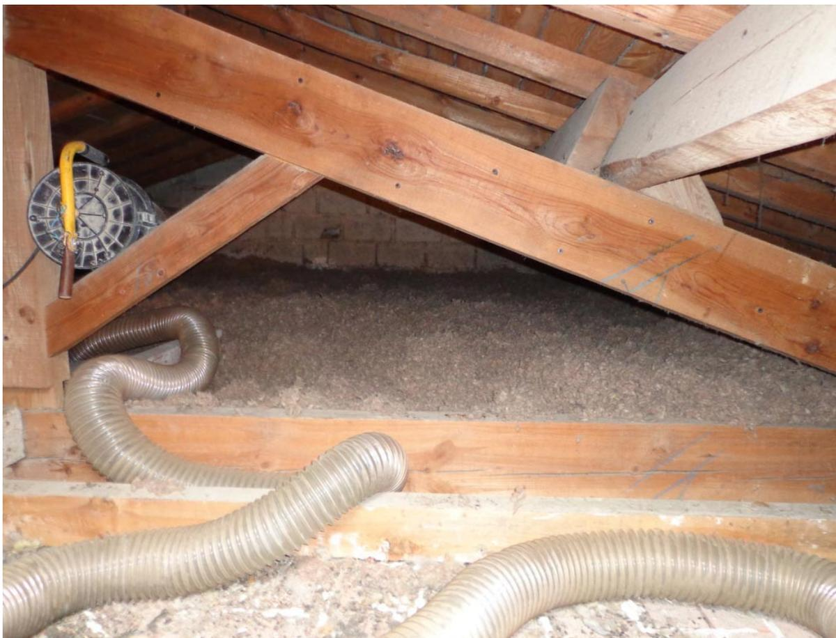
*Après enlèvement de l'ancienne laine de verre évacuée en centre de recyclage, repérage des boîtiers électriques et soufflage de laine de roche de marque Rockwool de type Jetrock sur une épaisseur de 32 cm pour un R=7.*
