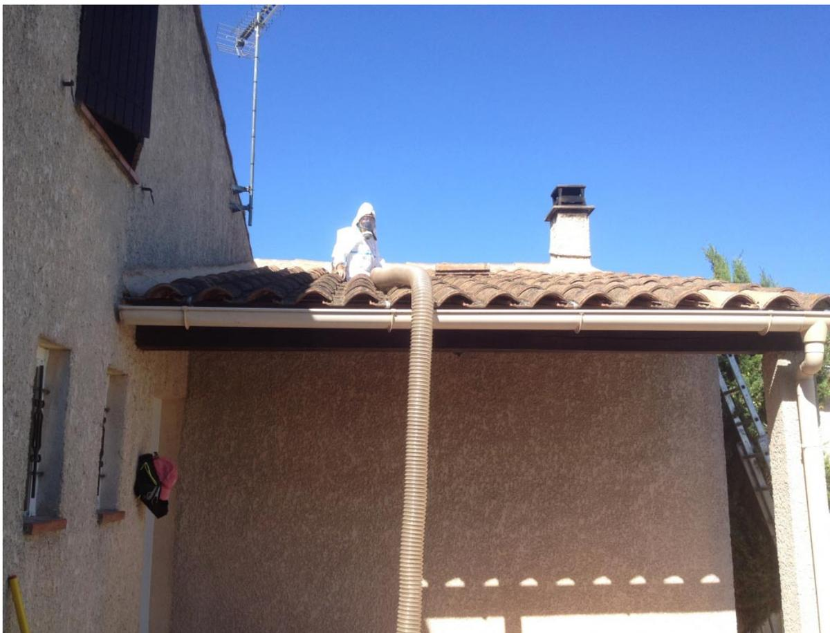
*Après pose de la VMC simple flux de marque Atlantic type Eolix, soufflage de laine de roche de marque Rockwool type Jetrock sur une surface de 65m<sup>2</sup> pour un R=7 soit 32 cm d'épaisseur.*
