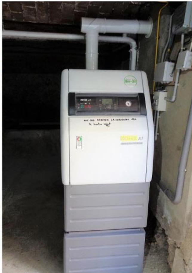
*Remplacement d'une chaudière gaz Propane que nous avons installée en 1999, par une chaudière à condensation fioul de marque Rotex munie d'une régulation en fonction de la T° extérieure. Evacuation des produits de combustion par ventouse horizontale de marque Jérémias. Désembouage installation avec solution Solutech de chez Permo et pose d'un pot à boues Dirtmag plus et d'une vanne de rinçage by-pass.*
