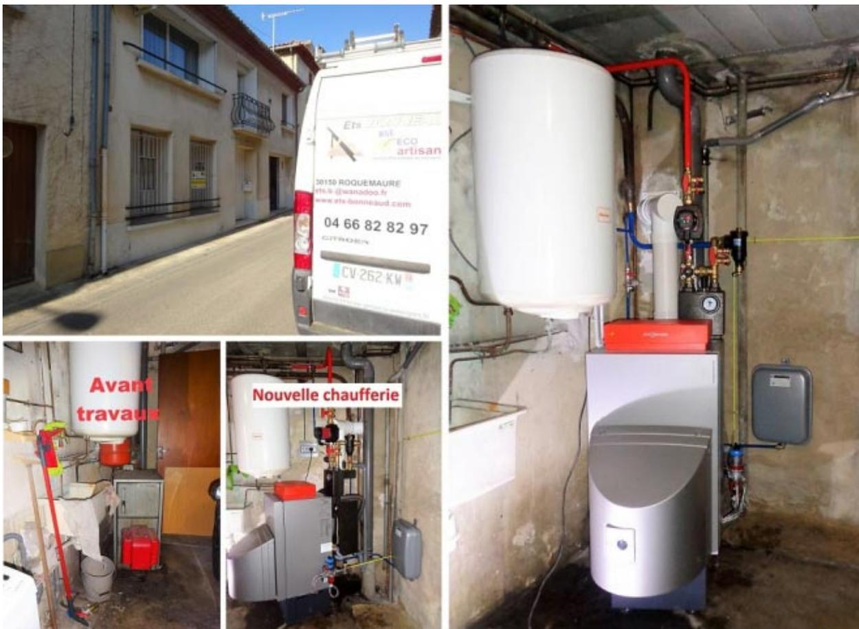
*Installateur Proactif Viessmann 30 GARD 84 VAUCLUSE Remplacement d'une ancienne chaudière fioul énergivore par une chaudière à condensation fioul de marque Viessmann modèle Vitorondens 200t avec régulation Vitotronic 200 en fonction de la T° extérieure.*
