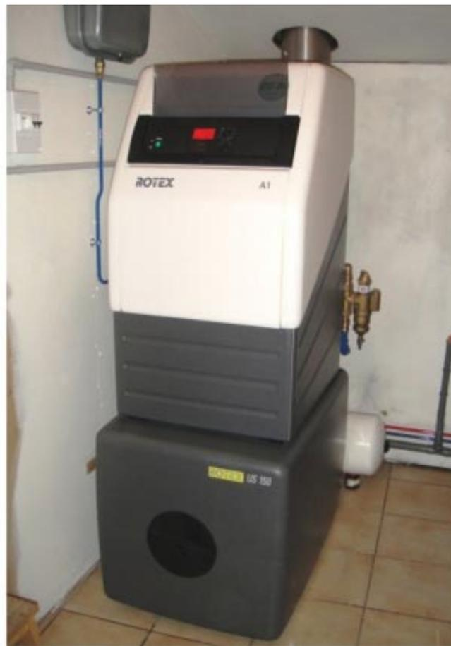
*Remplacement d'une ancienne chaudière fuel par une chaudière à condensation fuel de marque Rotex/Daikin avec ventouse verticale et production eau chaude sanitaire par ballon inox 150l et régulation Rocon en fonction de la température extérieure. Désembouage et traitement circuit radiateurs avec solution Solutech Permo avec filtre à boues. Ventouse verticale concentrique de chez Cheminées Poujoulat.*
