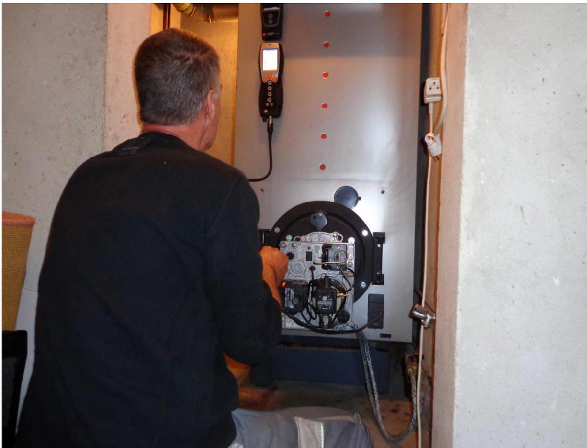
*Entretien annuel d'une chaudière fioul Viessmann qui comprend le nettoyage de la chaudière, du brûleur du filtre pompe, du remplacement du gicleur Danfoss et de l'élément du filtre fuel. Un contrôle électronique de combustion vient garantir un bon fonctionnement avec les performances qui sont requises*
