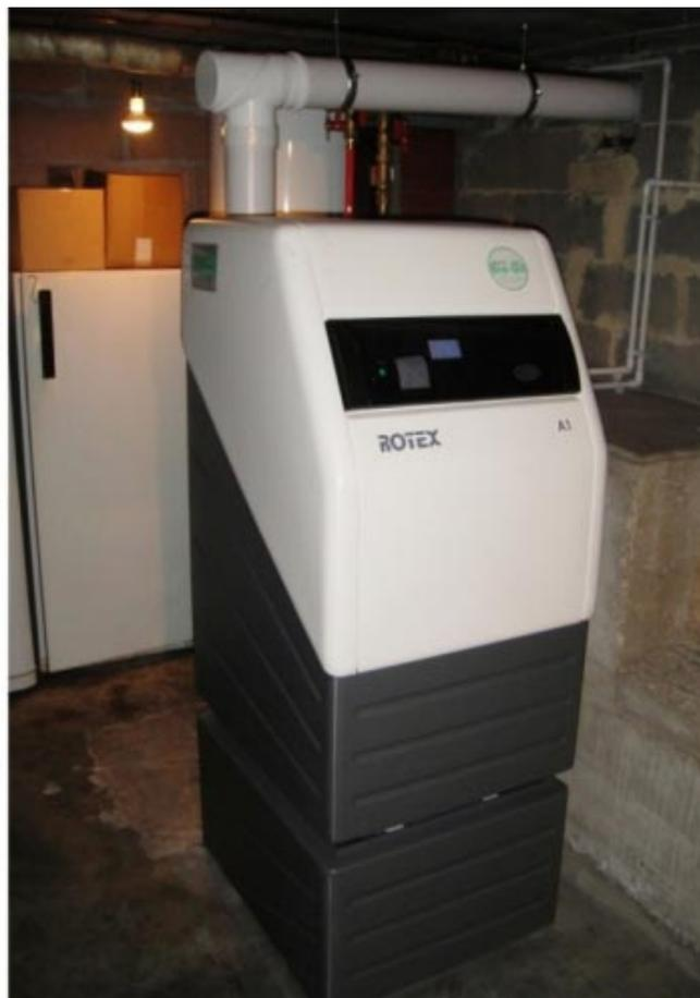
*Remplacement d'une ancienne chaudière fioulde 40ans très énergivore, par une chaudière à condensation fioul de marque Rotex/Daikin type A1 posée sur un socle. Deux vannes By-pass ont été installées afin de permettre un nouvel désembouage. Un pot à boues dégazeur de marque Permo est installé afin de protéger la nouvelle chaudière. Ventouse verticale de chez Cheminées Poujoulat dans conduit existant.*
