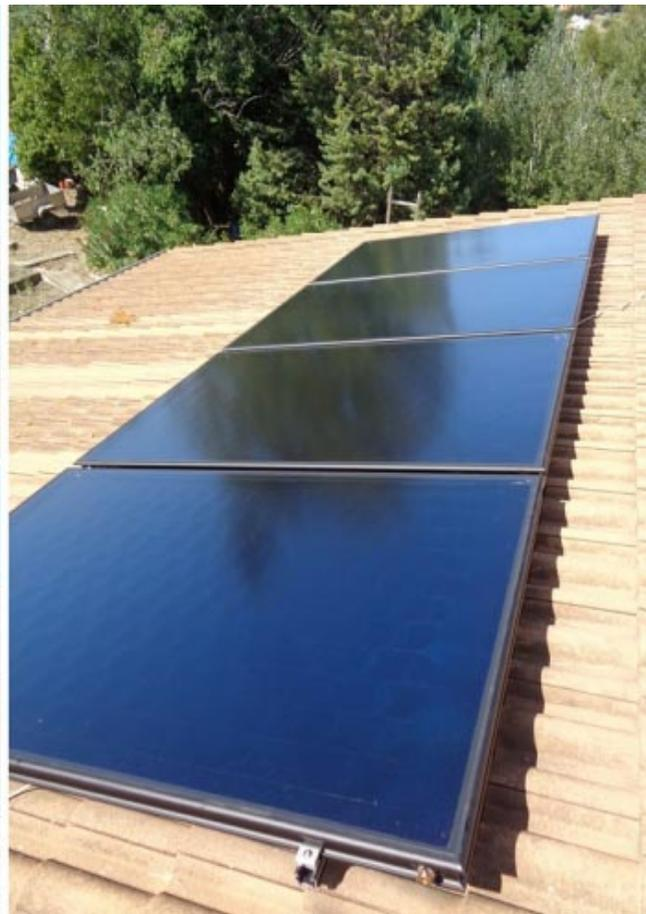
*Mise en place d'un combiné solaire thermique de marque Rotex/daikin pour assurer la production d'eau chaude sanitaire et un appoint chauffage en hiver.*
