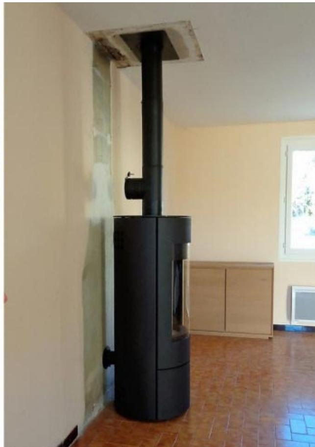
*En remplacement d'une ancienne cheminée à foyer ouvert peu performante, mise en place d'un poêle bois bûches de marque Supra modèle Maud avec tuage conduit en inox et raccordement au conduit en tube acier émaillé noir de marque Jérémias. Un régulateur de tirage vient garantir un tirage n'excédant pas 20Pa par jour de fort mistral. Carottage du mur pour l'arrivée d'air raccordée directement sur le poêle.*
