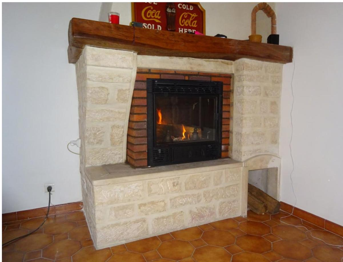
*Dans un foyer ouvert peu performant, mise en place d'un insert Supra 652 ne nécessitant pas de tubage et mini de deux turbines qui aspirent l'air en bas et le rejettent en partie haute.*
