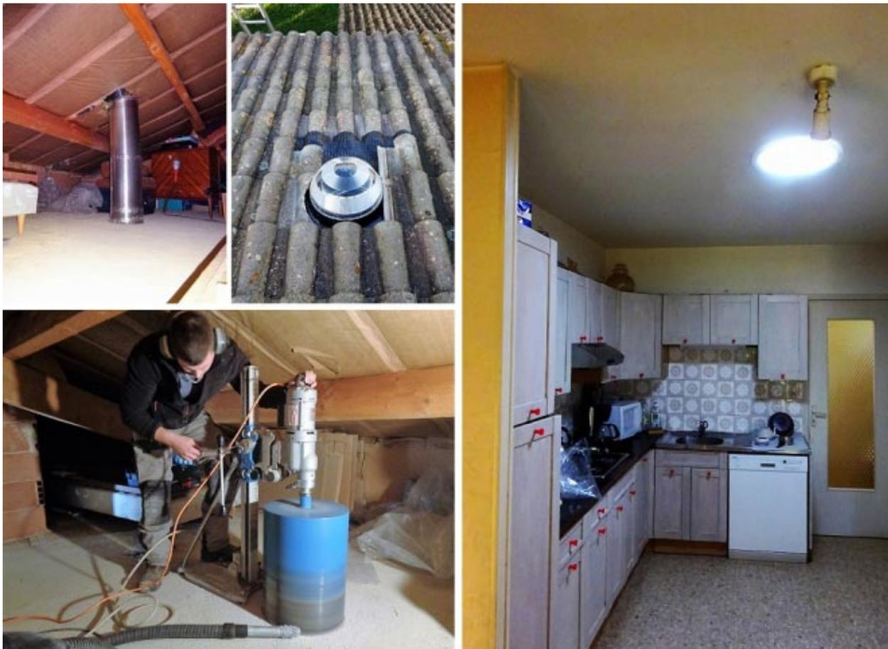
*Dans une cuisine mal éclairée, mise en place d'un puits de lumière de marque Solatube modèle 290DS d'un  $\varnothing$  de 35cm avec carottage de la dalle béton. Le plus lumineux des puits de lumière dans, 13 Bouches du Rhône, 30 Gard, 84 Vaucluse.*
